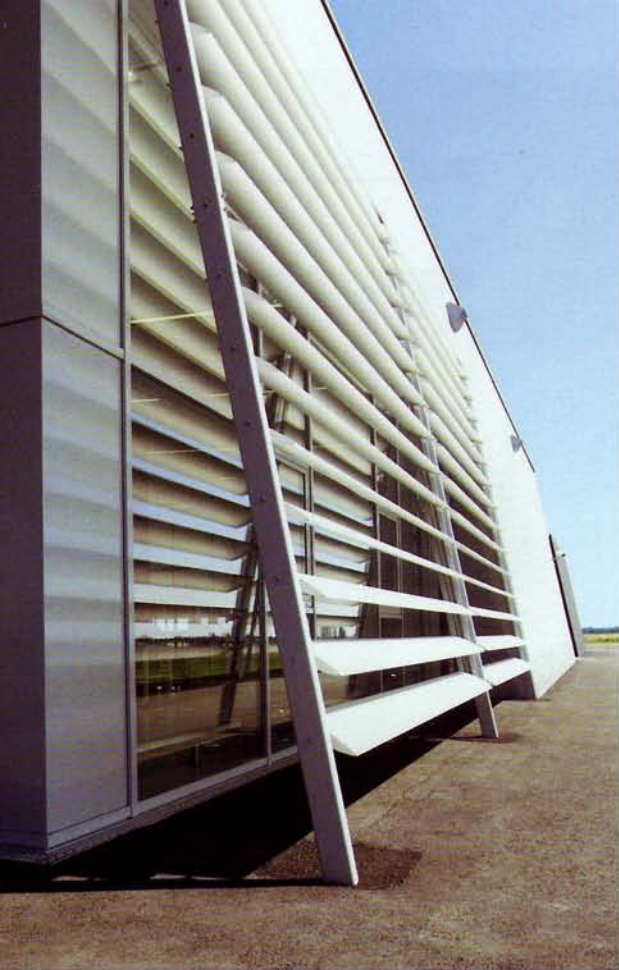
Lamellenfassade Produktionstrakt
