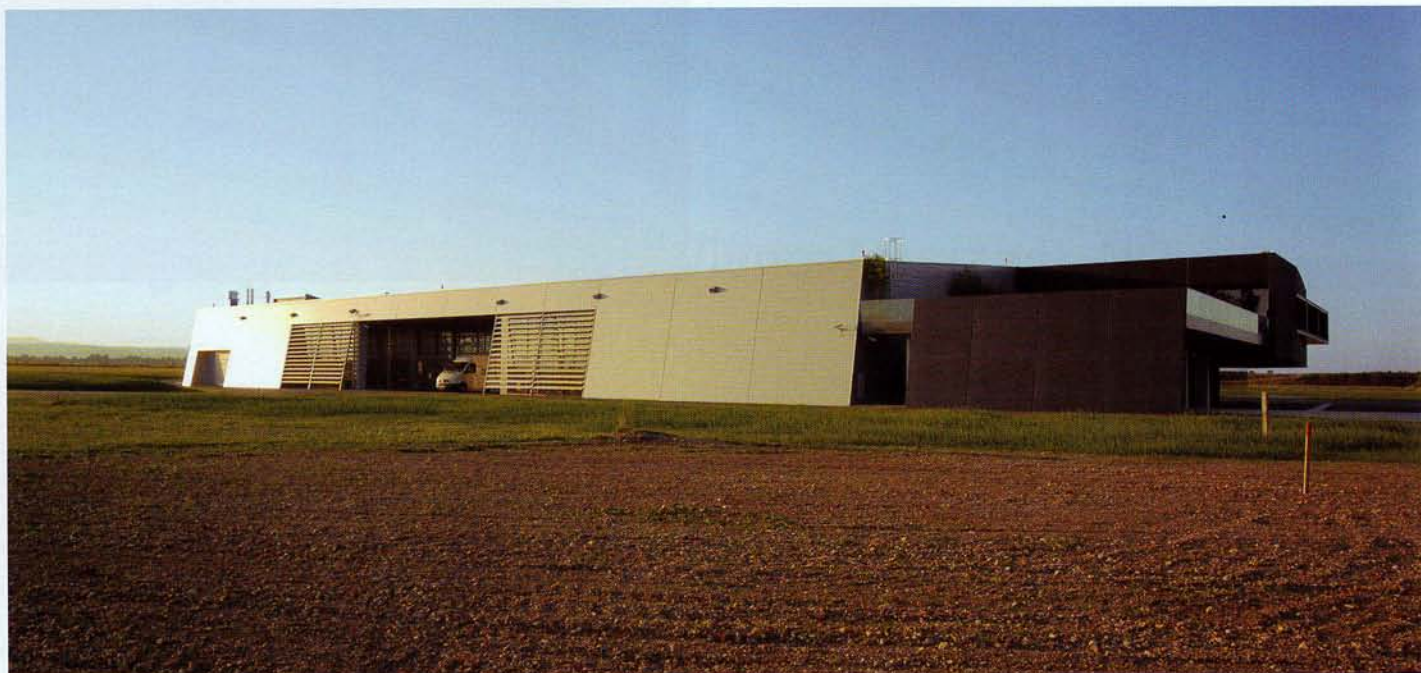
Fertigungshalle zum Flugfeld orientiert
